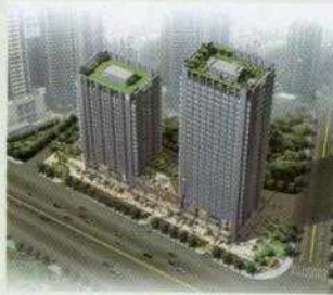
钛合国际 工程地点：杭州 项目规模：50000平方米
